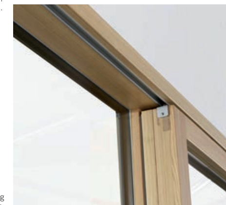
Elegant bündig versenkte Laufschiene.
