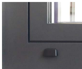
Entwässerungsschlitze mit sichtbarer Abdeckkappe
