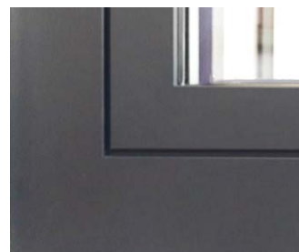
Verdeckte Entwässerung
